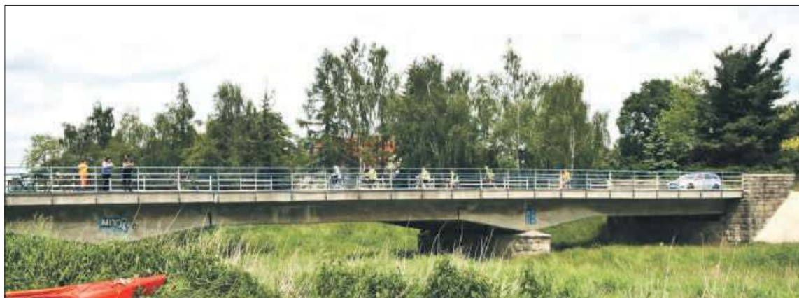
Obecny most zostanie rozebrany
