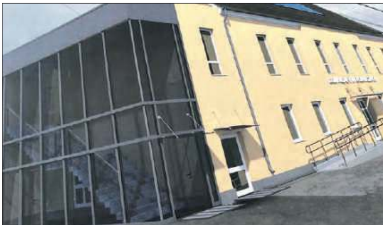
Wizualizacja budynku Wiejskiego Domu Kultury w Raclawiczkach po zakończonym remoncie
