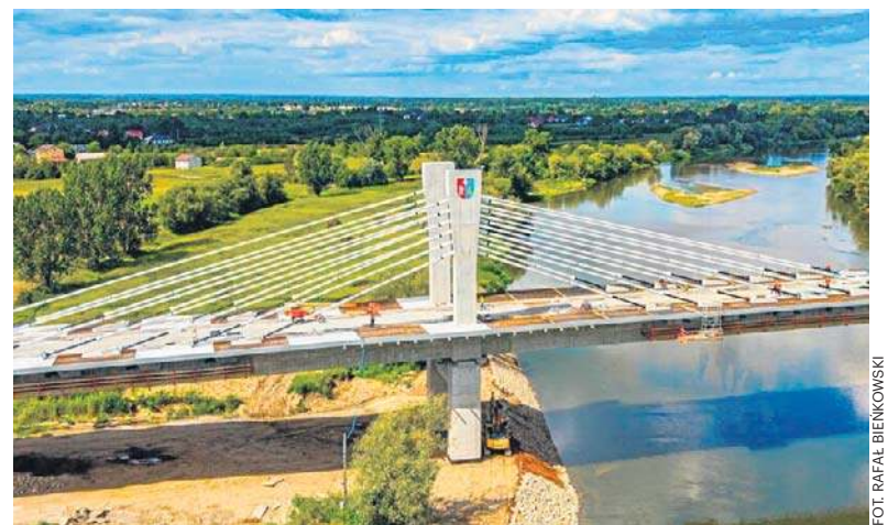
Budowa powinna zakończyć się w listopadzie
