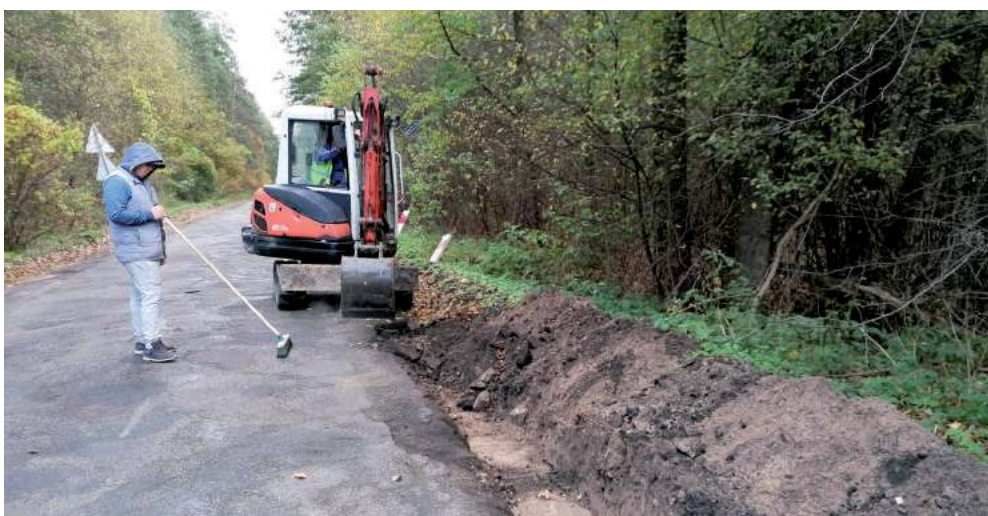
Prace w Trzebieszy ruszyły na nowo 11 października. Koparka kopata rów na poszerzenie jezdni. Docelowo szerokość jezdni ma powiększyć się o metr
