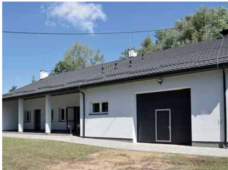
Świetlica wiejska w Strzembowie
