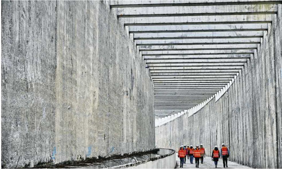
• Budowa tunelu średnicowego w Łodzi
