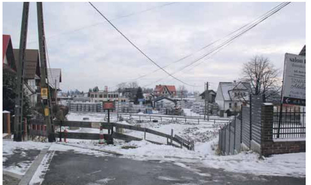
Ulica Bolesława Wstydliviego kończy się skarpą i schodkami, a ma dołączyć do pobliskiej obwodnicy.
