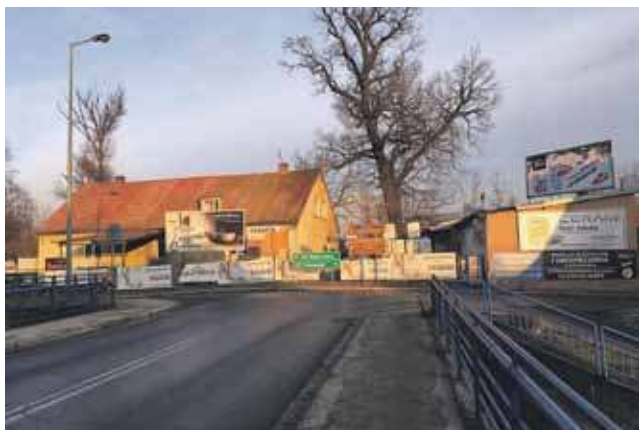
Chodnik ma w tym miejscu zaledwie kilkadziesiąt centymetrów szerokości.
