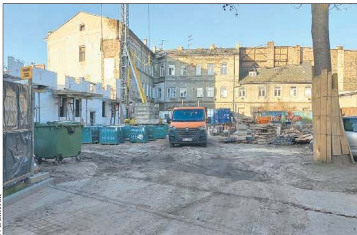
Prace budowlane przy ul. Sienkiewicza 46
