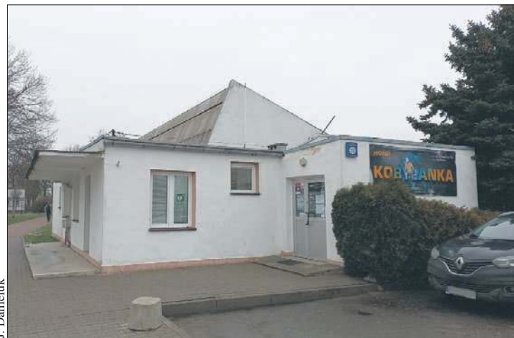
Pływalnia miejska przy Al. Kobylńskiego będzie funkcjonować przynajmniej do otwarcia nowego obiektu, który powstaje nieopodal
