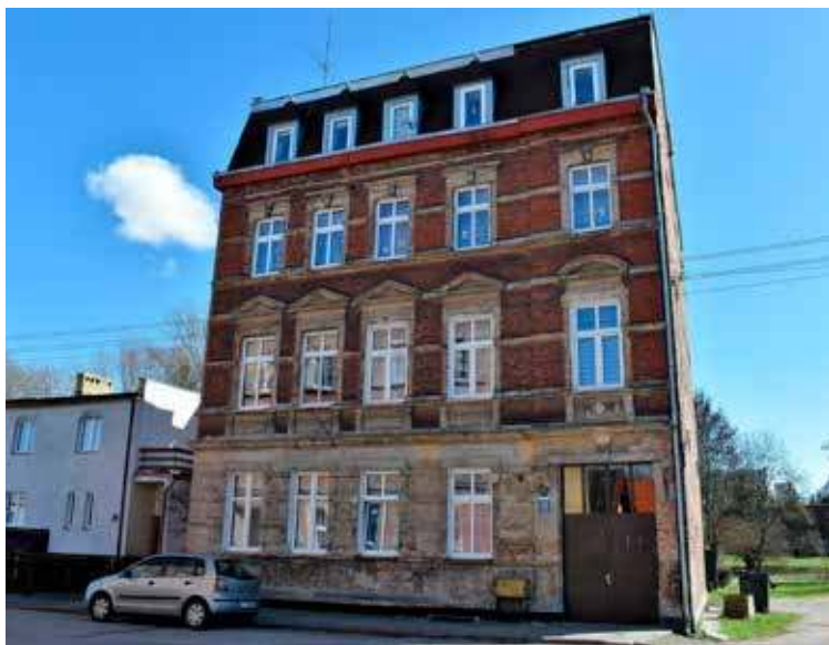
Kamienicę przy ulicy Młyńskiej 10 czeka całkowita renowacja. Z klatki znikną toalety, wyremontowane zostaną piwnice, elewacja budynku odzyska dawny blask
