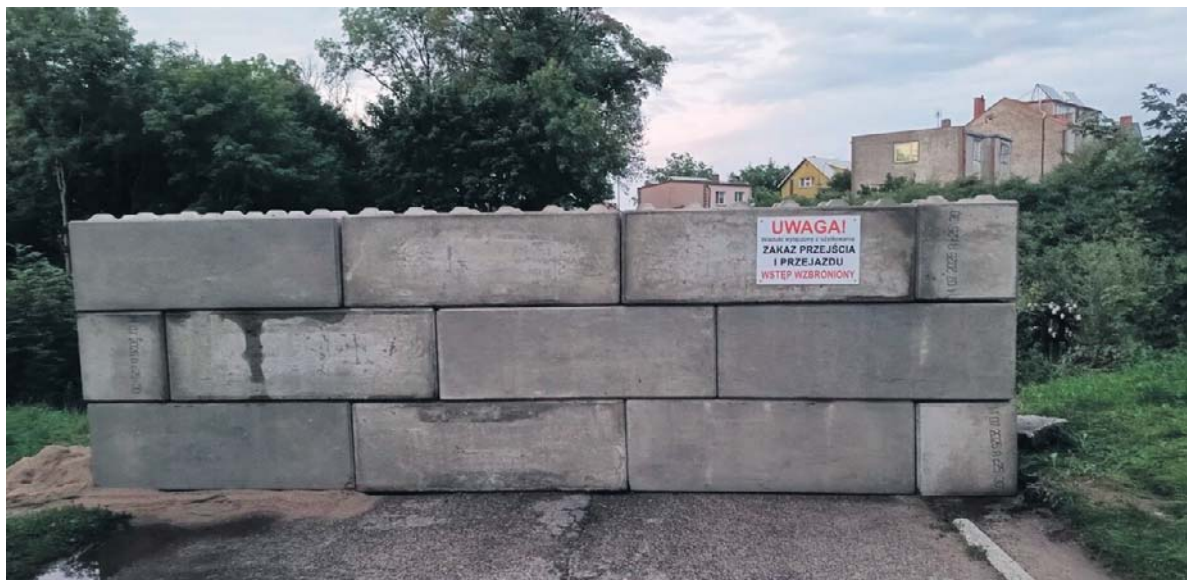
Na wiadukcie w Połczynie-Zdroju został wybudowany mur
