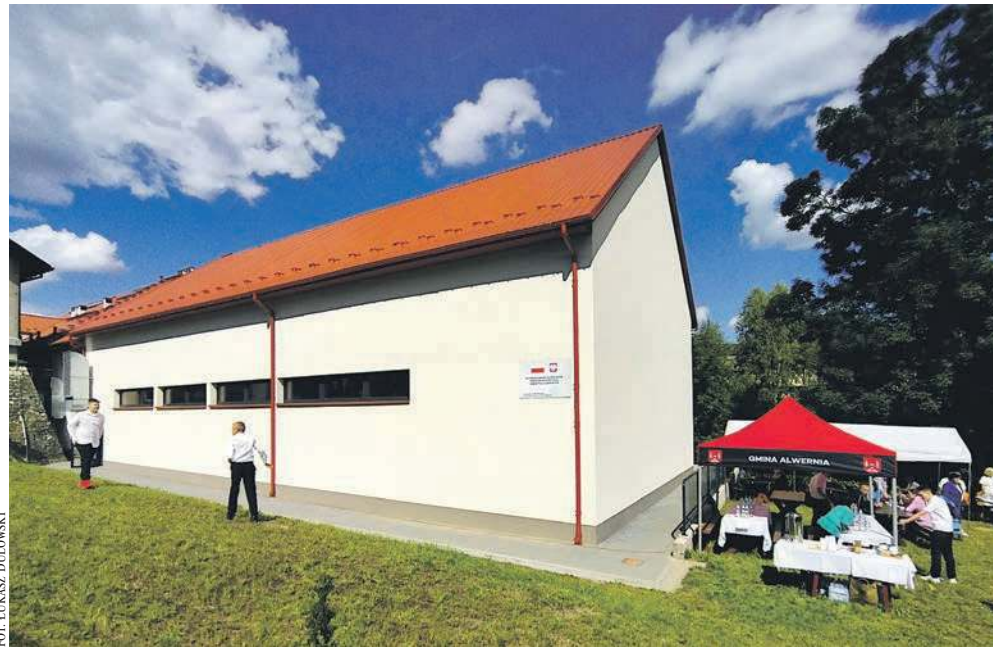
Rozbudowa podstawówki w Grojcu została zakończona z 274-dniową zwłoką
