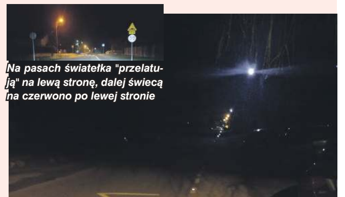
Białe światelka wyznaczają w Księginicach prawy kraniec jezdni. Obok znajduje się pas-pobocze, po którym mogą poruszać się piesi
