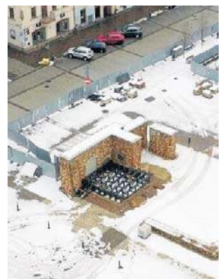
Remont rynku w Olkuszu jest na ukończeniu
