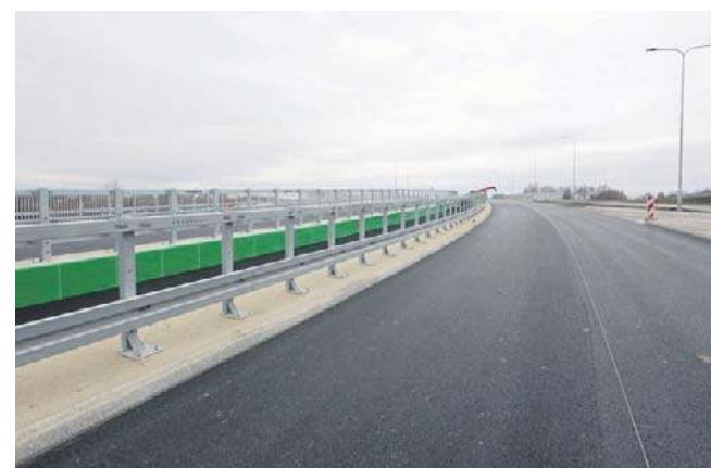
Kluczowym krokiem do dopuszczenia obiektu do ruchu będą testy wytrzymałościowe
