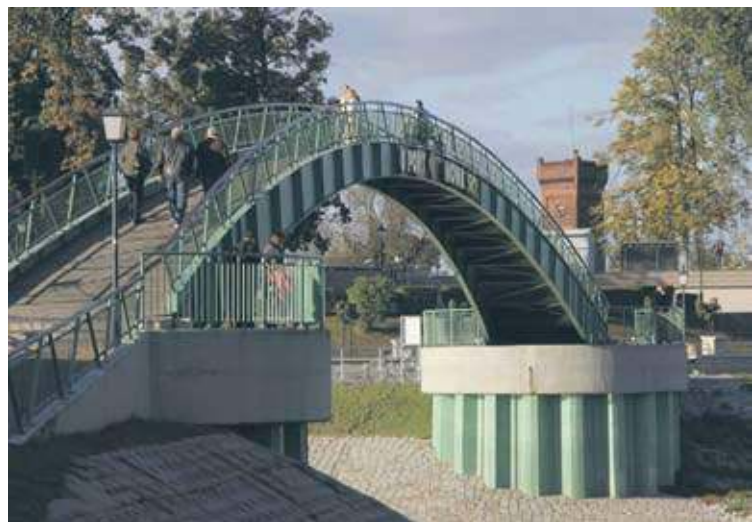
Dziś, tj. we wtorek 30 kwietnia włączona zostanie iluminacja kładki
