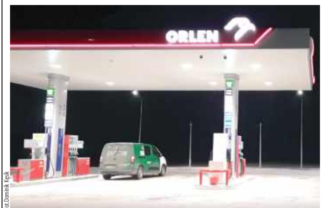
Pierwsi klienci zatankowali na Orlenie kilka dni temu. Stacja paliw znajduje się obok drogi ekspresowej S17
