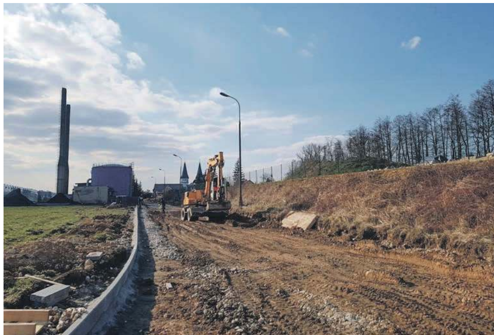
Nowa droga połączy drogę krajową 79 z ul. Żbicką
