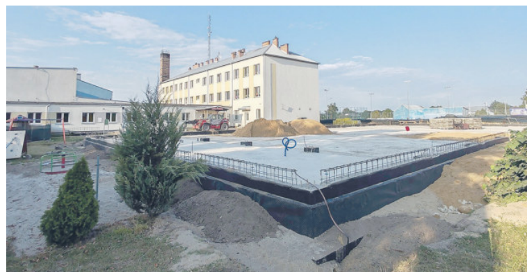
Budowa hali w Trzebieszowie Drugim
