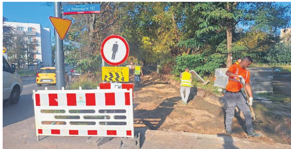
Droga rowerowa wzdłuż ulicy Pomorskiej ułatwi dojazd rowerem m.in. do CKD i pozwoli ominąć zatłoczoną jezdnię
