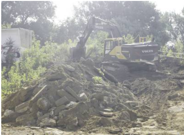
Prace rozbiórkowe potrwać ok. 3 tygodnie.
