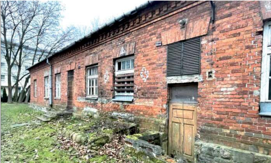
W budżecie na rok 2024 zaplanowano środki na realizację inwestycji, która polegać będzie w szczególności na kapitalnym remoncie dachu, wykonaniu nowej instalacji odwodnieniowej dachu oraz instalacji odgromowej
