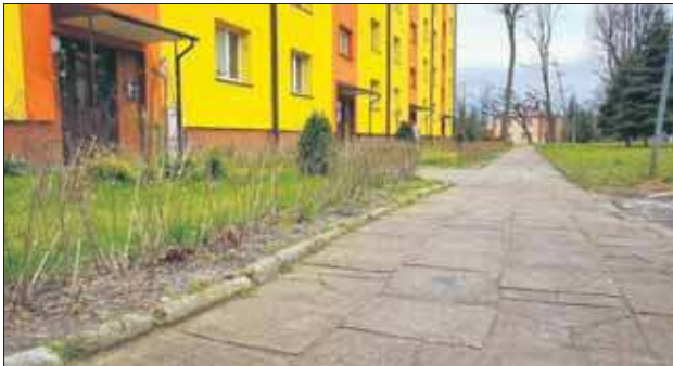
Prace mają zakończyć się do końca października (foto. UM Jaworzno)
