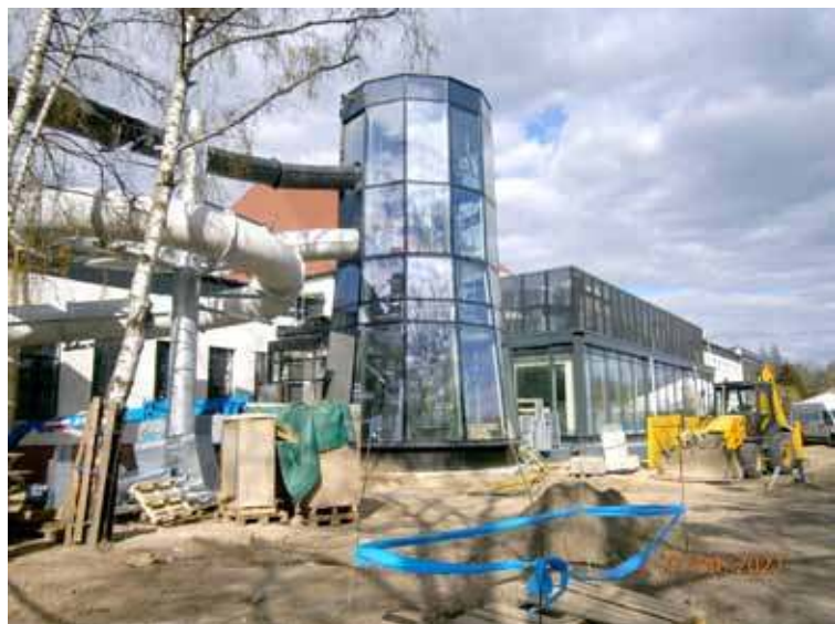
Oczekiwana przez mieszkańców inwestycja niestety, jak na razie, ma kolejne opóźnienia
