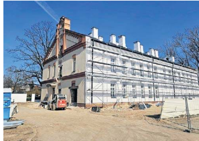
Remont budynku Instytutu Muzyki UMCS zrobiony jest w trzech czwartych. Będzie kosztował 11 milionów zł
