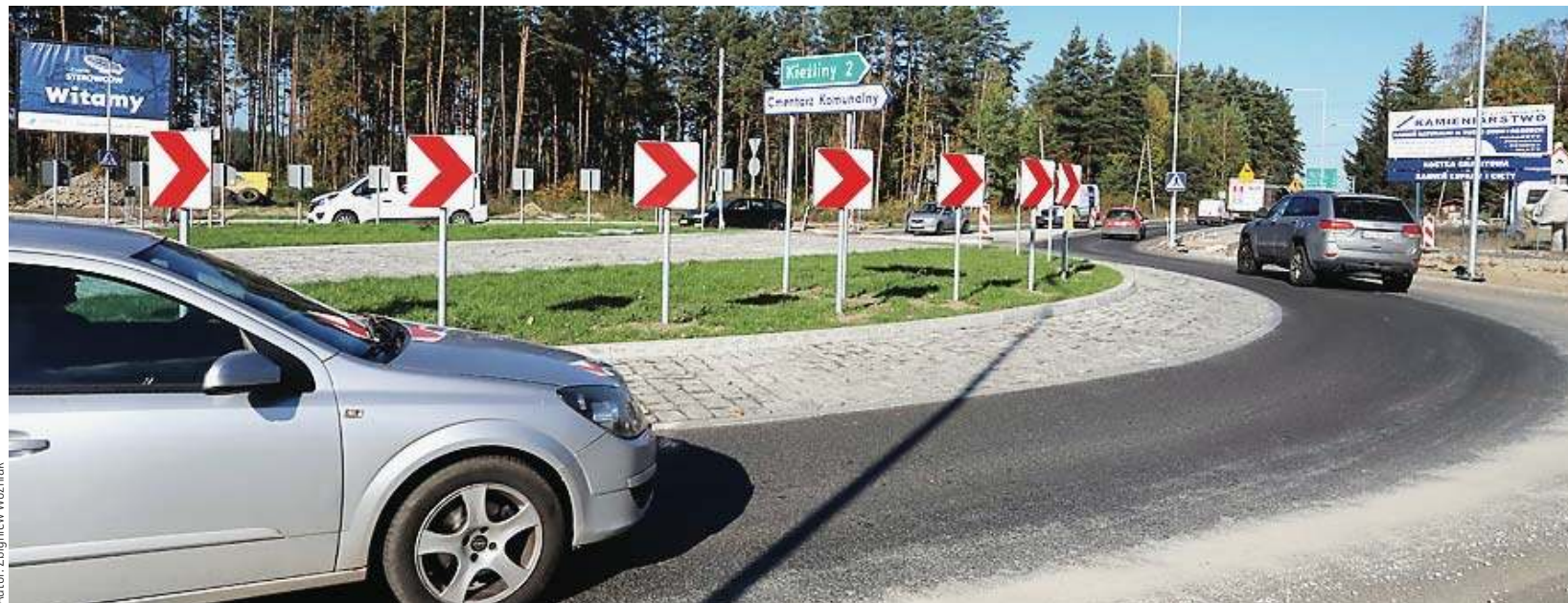
Budowa obwodnic Olsztyna i Dywit zakłada też remont dk51 przez Las Miejski
