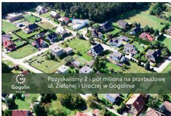
Ulice Zielona i Uroczna w Gogolinie będą przebudowane.
