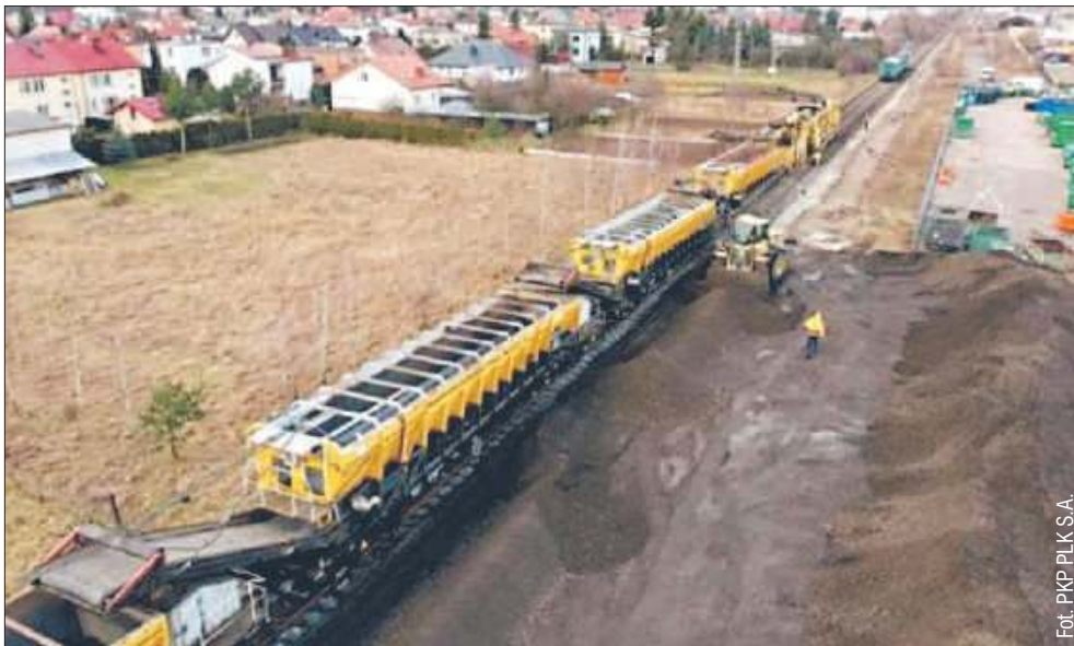
Prace modernizacyjne na 32-kilometrowym odcinku Mielec-Dębica dobiegają końca.
