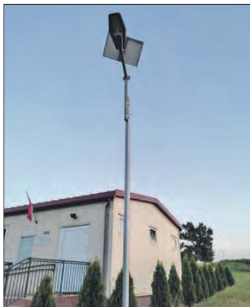
Nowa lampa przy wiejskiej świetlicy w Jasieniu
