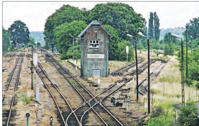
Stacja w Raclawicach ponownie może stać się węzłem kolejowym
