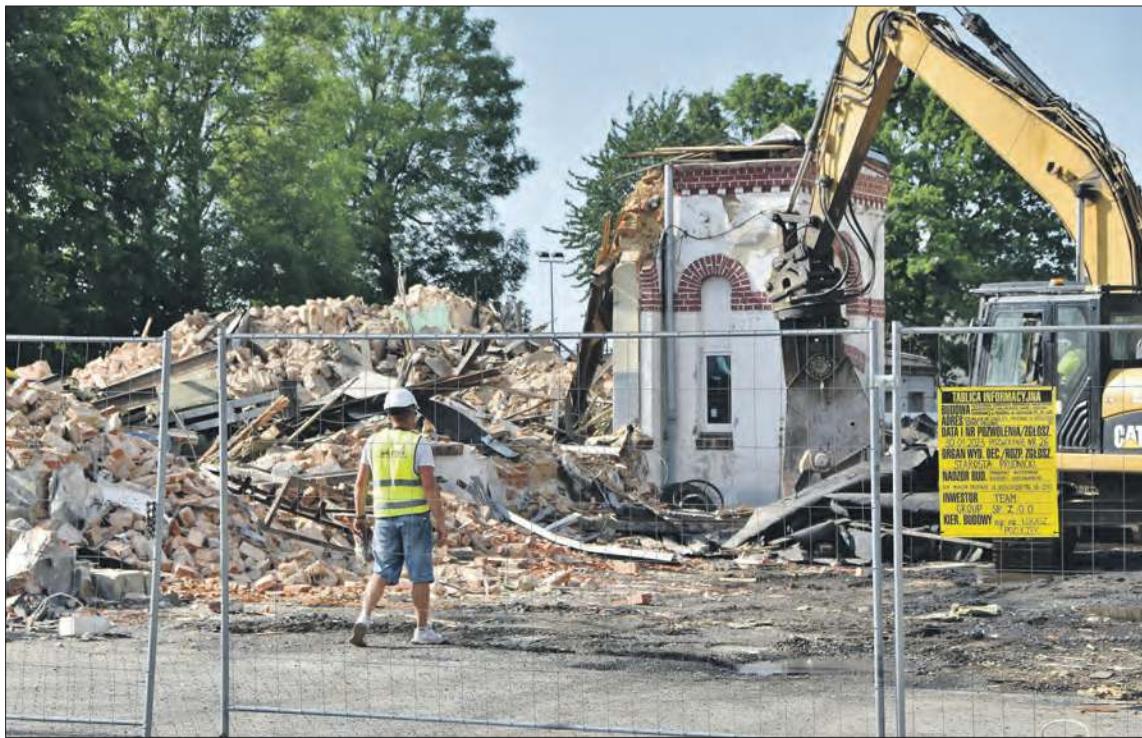
Rozbiórka budynku fabryki dzianiny, a później warsztatów PKS-u
