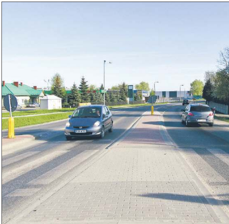
Po prawej stronie ul. Drogowców w Dębicy powstanie ścieżka rowerowa, którą będą mogli chodzić piesi, po lewej chodnik będzie remontowany.
