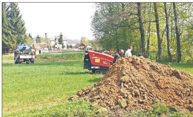
Wodociąg w Woli Brzostckiej jest już budowany.
