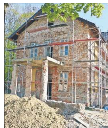
Tak wygląda dawna siedziba Urzędu Gminy obecnie. Prace budowlane trwają.
