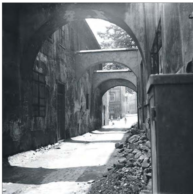
Ulica Kościelna w 1963 r. podczas prac remontowych z trzema „nowymi” łukami
