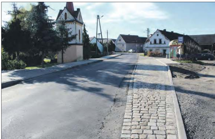
Nowy chodnik i zatoka przystankowa w Rączce
