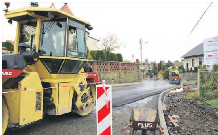
Budowa drogi w Gryżowie
