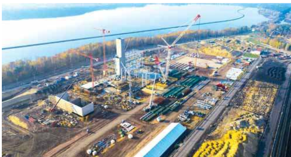
Nowo budowany blok gazowo-parowy w Rybniku
