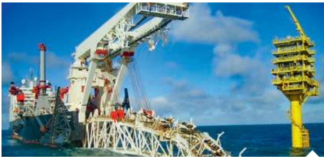
Oprócz rosyjskiej „Fortuny” przy budowie Nord Streamu 2 pracują też dwa polskie statki | fot. mat. pras./d
