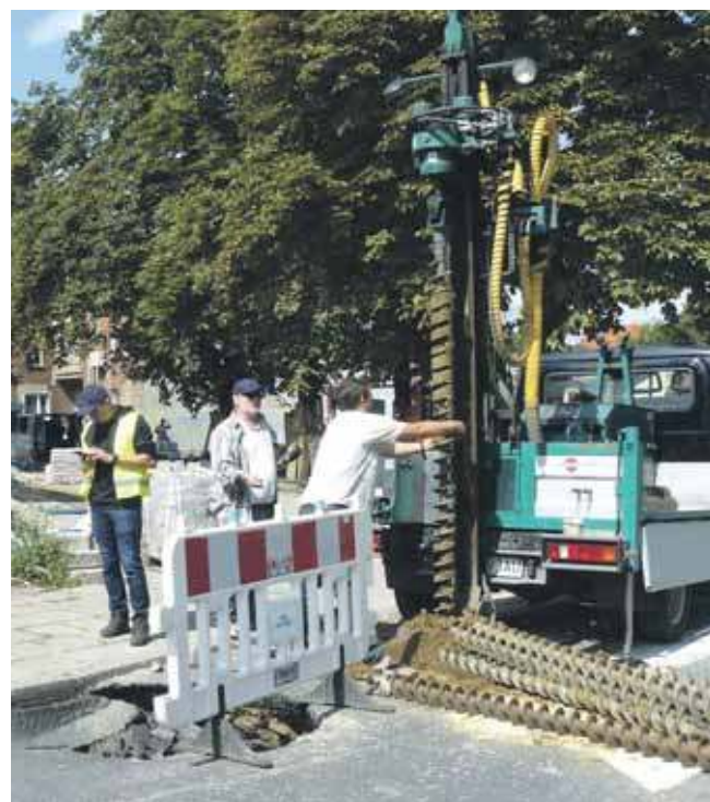
W ubiegłym tygodniu w rejonie zapadlisk wykonywano odwierty FOT. AGNIESZKA RECZKIN
