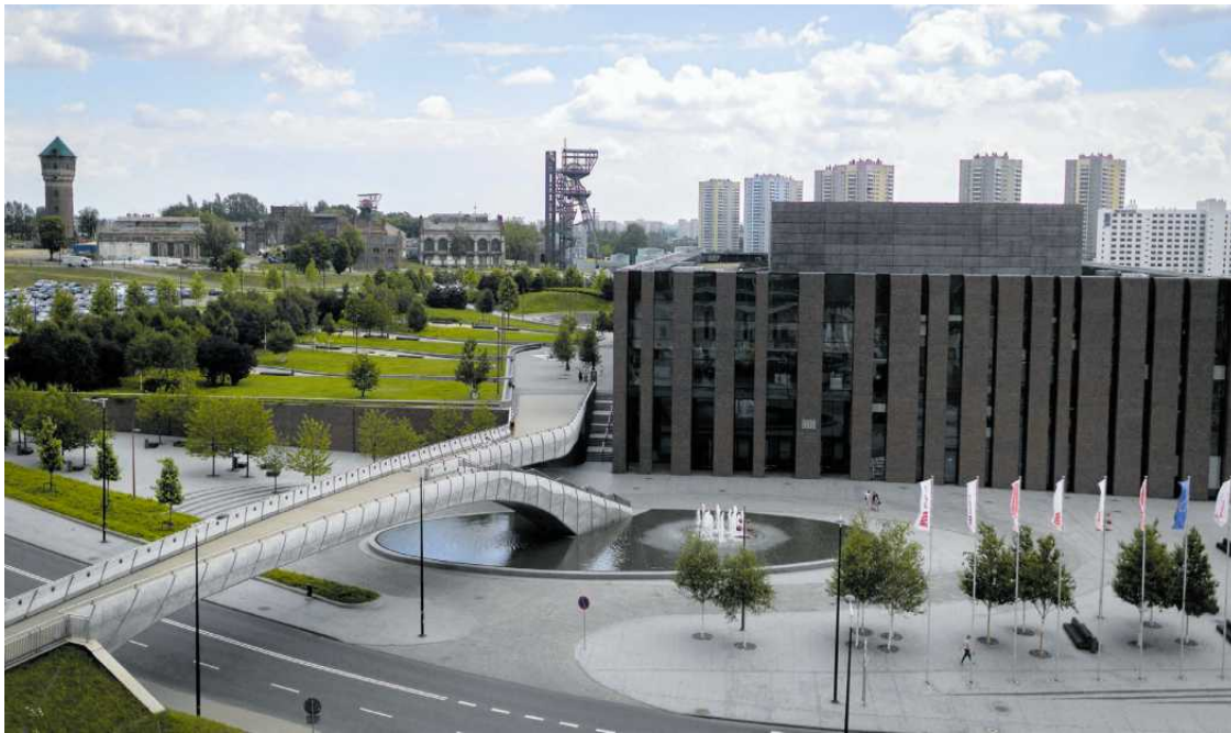
• Nowy gmach Narodowej Orkiestry Symfonicznej Polskiego Radia w Katowicach
