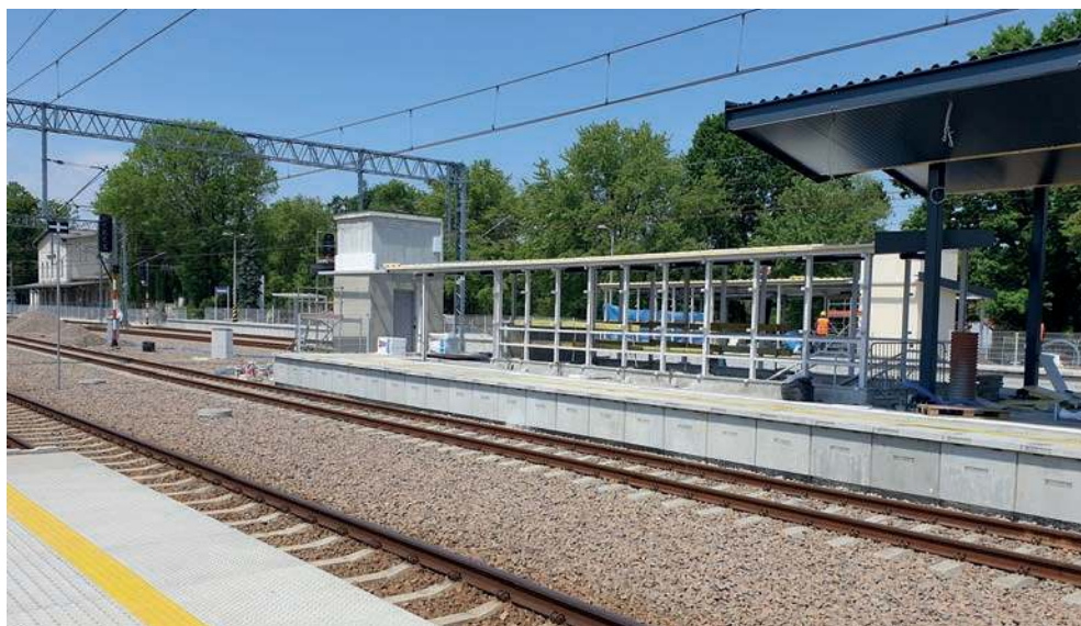
Widok na wejście do przejścia podziemnego na peronie drugim
