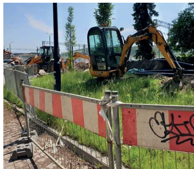
Prace nadal trwają także nieopodal budynku dworca
