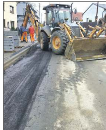
Prace przy gminnej drodze w Prężynie
