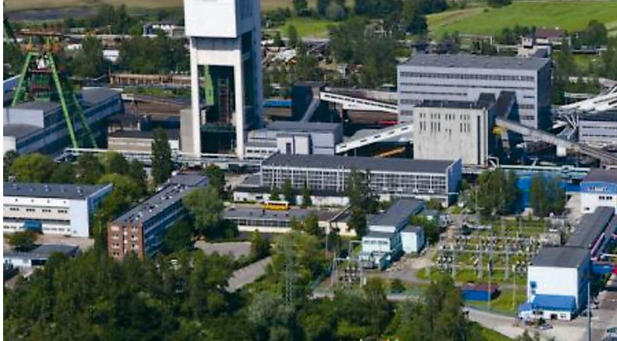
Nowy blok w elektrociepłowni Zofiówka w Jastrzębiu-Zdroju to kluczowy element bezpieczeństwa energetycznego JSW | fot. mat. pras./d
