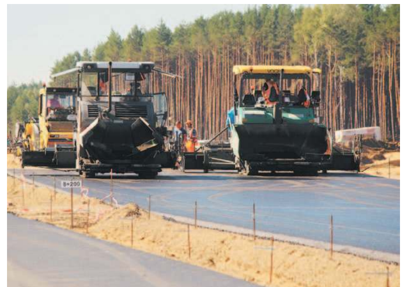
Odcinek od węzła Lasy Janowskie do węzła Zdziary ma długość 9,5 kilometra. Do tej pory wykonano 35 proc. prac na odcinku Lasy Janowskie – Zdziary
