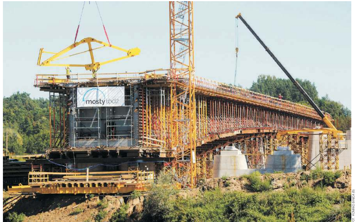
W Zarzeczcu powstaje 390-metrowy most przez San
