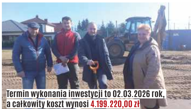
Ruszyła budowa strażnicy OSP Wilga
