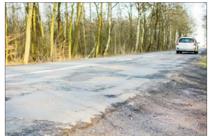
Właśnie rozpoczęła się przebudowa niewyremontowanego odcinka ul. Grodzisko. Za trzy miesiące nawierzchnia ma być równa jak stół.
