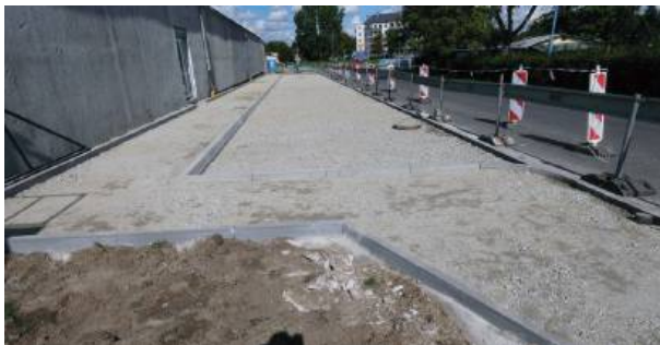
Nowy odcinek remontowanej drogi z chodnikiem przy budynku i głębszymi parkingami
