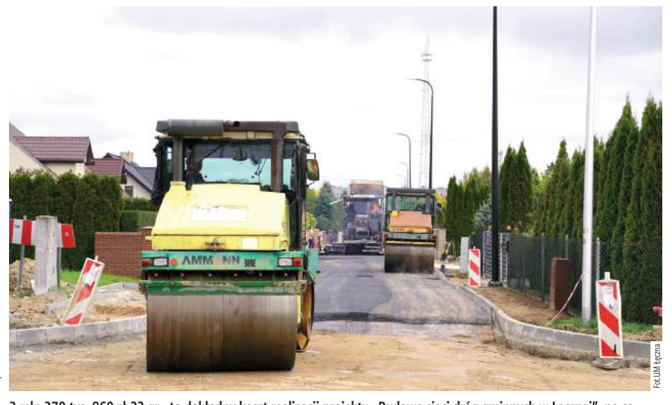
3 mln 379 tys. 869 zł 23 gr - to dokładny koszt realizacji projektu „Budowa sieci dróg gminnych w Łęcznej”, na co miasto pozyskało 95 procent dofinansowania
