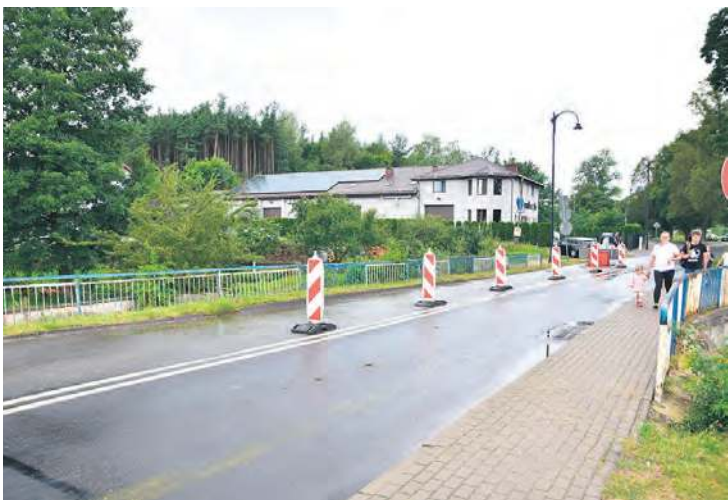
Część mostu już od kilku miesięcy jest wyłączona z ruchu.
