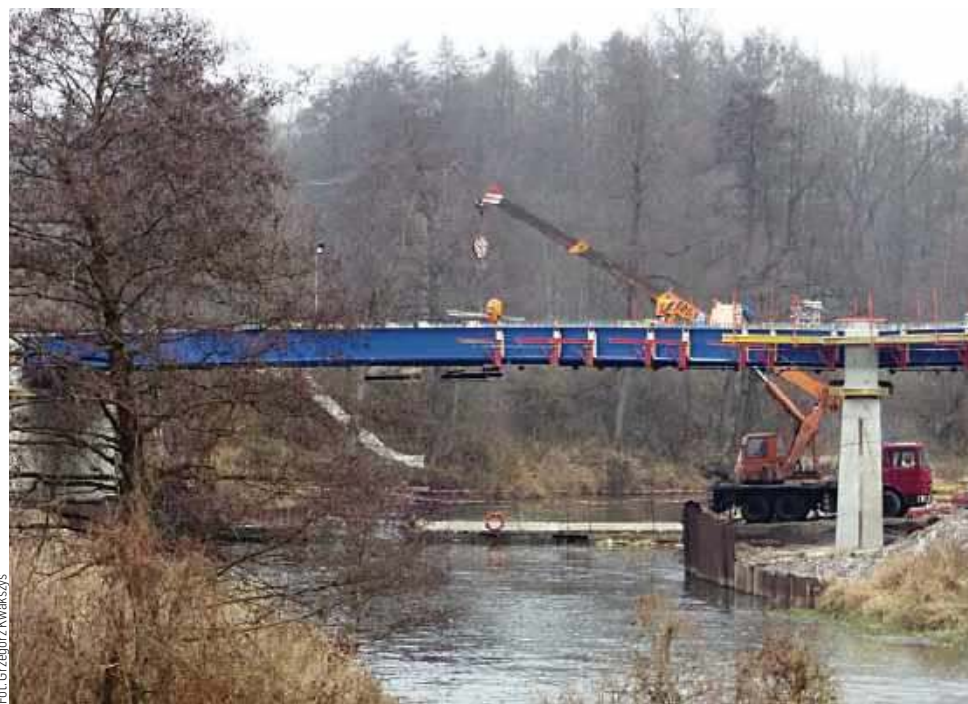
Na tempo prac przy budowie mostu wpływają m.in. dobre warunki pogodowe
