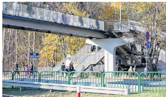
Aby sprawdzić stan konstrukcji, wykonana będzie szczegółowa ekspertyza
