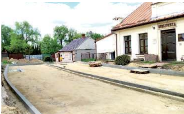
Na Starym Mieście kontynuowana jest budowa kanalizacji deszczowej i oświetlenia, trwają roboty drogowe przy konstrukcji i nawierzchni nowych dróg, parkingów i chodników.
