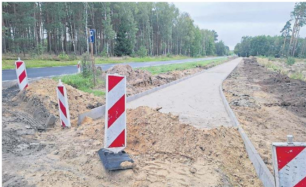
Inwestycja przewiduje budowę ciągu pieszo-rowerowego o długości 3,6 kilometra. Całkowity koszt zadania wynosi 6,3 mln złotych
