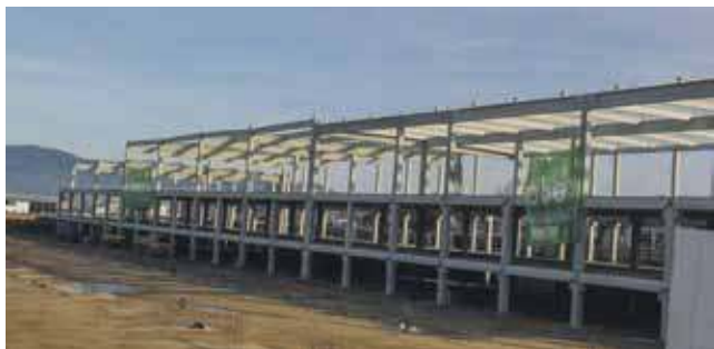
Na budowie Galerii Podhalańskiej cisza.
