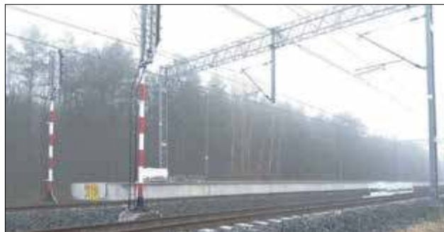
Do budowanego przystanku Biała Podlaska Wschodnia prowadzić ma podziemne przejście od ul. Siderskiej
