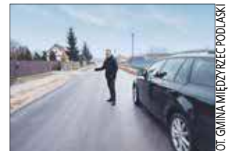
Widoczne są już pierwsze efekty największej z obecnie prowadzonych inwestycji drogowych na terenie gminy Międzyrzec Podlaski. Chodzi o remont blisko 10 km nawierzchni na drogach nr 1006L i nr 1007L
