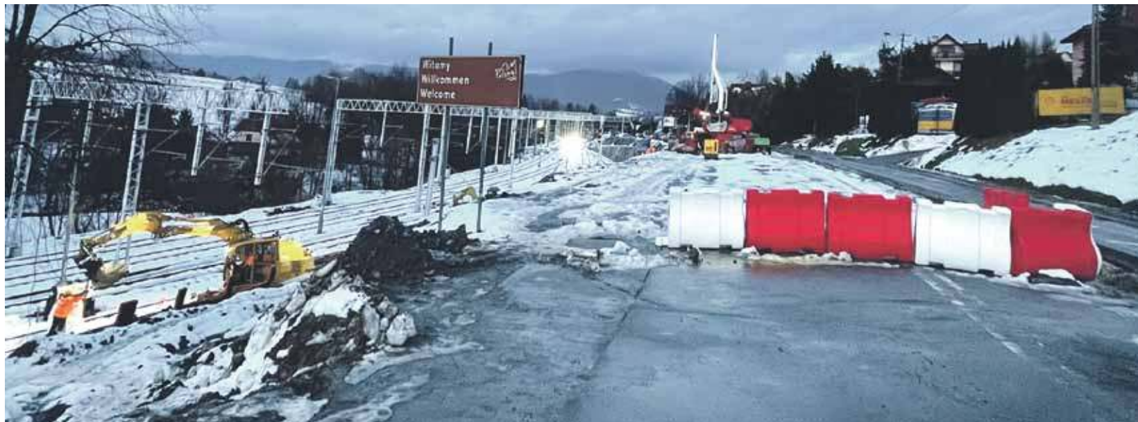
Prace przy zabezpieczeniu skarpy, rozdzielającej drogę i torowisko, zostały już zakończone.
